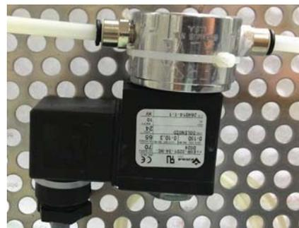
(b) Électrovanne commandant l'ouverture des vannes entrée/sortie
