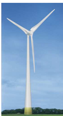
(a) Éolienne réelle Enercon
