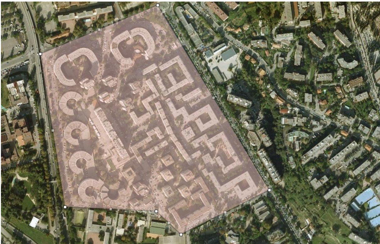
Figure 28 : Exemple de grands ensembles de la ville de Nice Source : Google Map, 2013.
