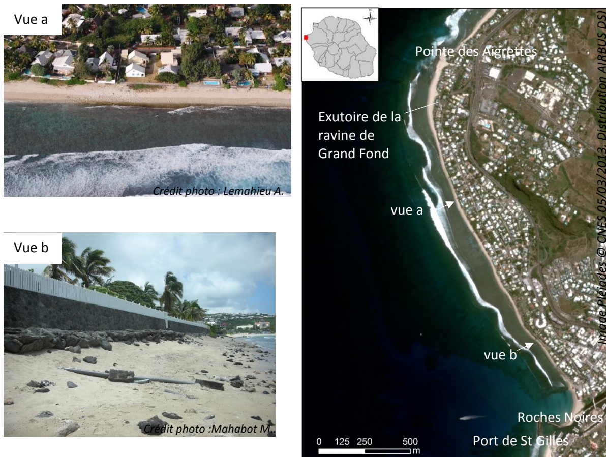
Figure 3-16: Eléments remarquables du paysage de la plage de Grand Fond. Vue a : Urbanisation empiétant sur l'estran ; Vue b : Erosion de la base des constructions anthropiques dans le secteur de Roches Noires
