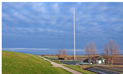
FIGURE I.4 – Station de mesure atmosphérique de Lutjewad, Province de Groningen, Pays-Bas. Son mât de 60m permet de réaliser la mesure de gaz à différents niveaux. Réseaux ICOS et InGOS.
