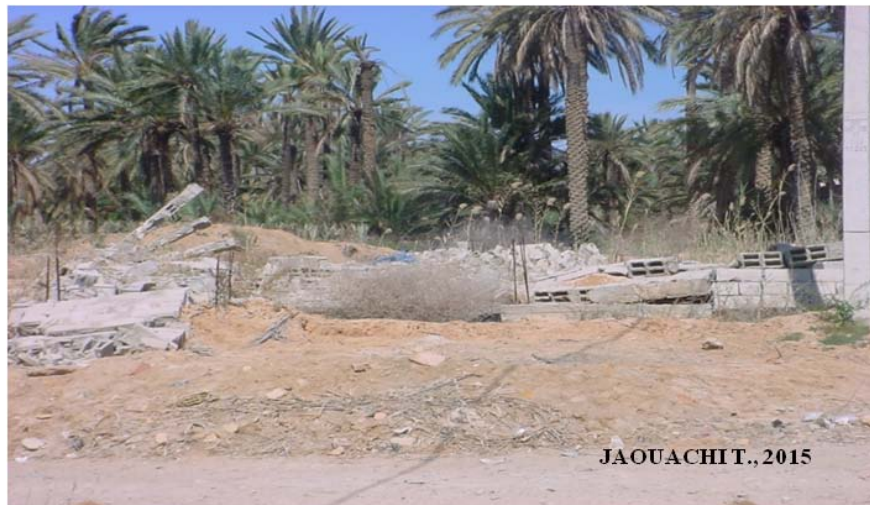
Photo 29 : Démolition d'une construction sans autorisation dans l'oasis de Gabès
