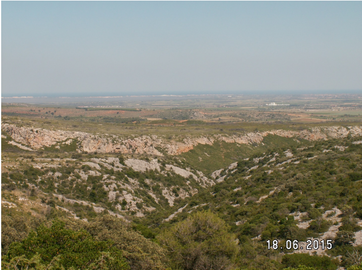
Fig. 8. Confluence des lignes d'eau qui a favorisé l'apparition d'un AFF. Le feu provenait de la gauche et a embrasé en une minute tout le bas du thalweg (partie droite de la photo)
