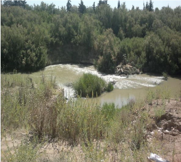
Photo 5 : oued Medjerda et le seuil d'une station de pompage à Ouifek
