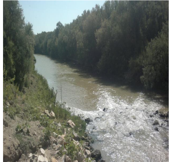
Photo 6 : oued Medjerda en aval des stations de pompage de Ouifek
