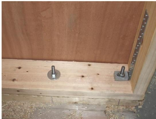
**Figure III-48** : Fixation de l'élément de mur sur la table vibrante
