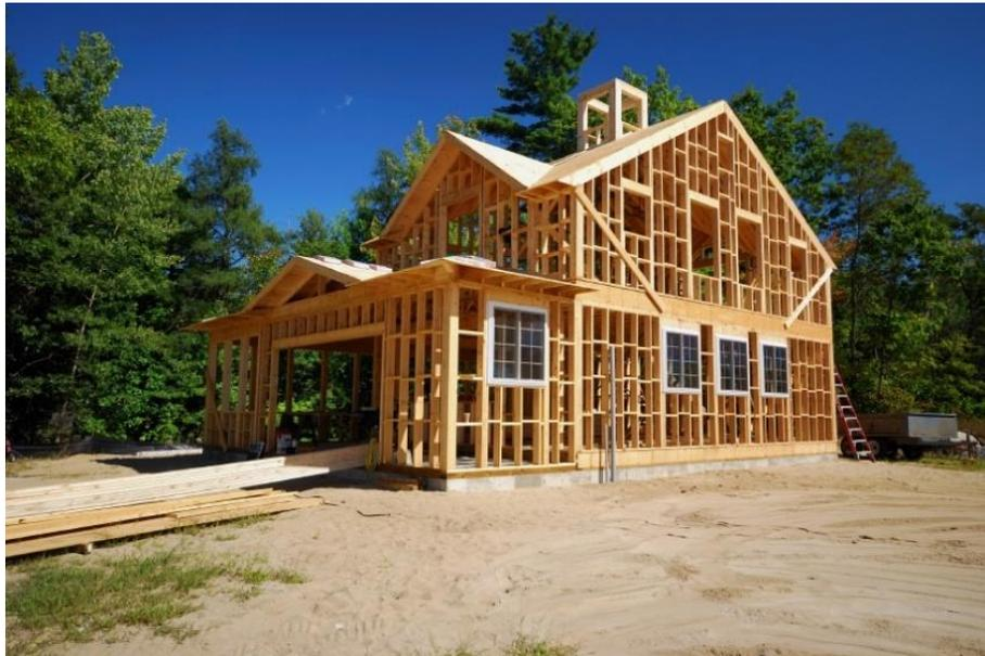
Figure I-2 : Exemple de maison individuelle en ossature bois (CBH - construction bois, 2015)
