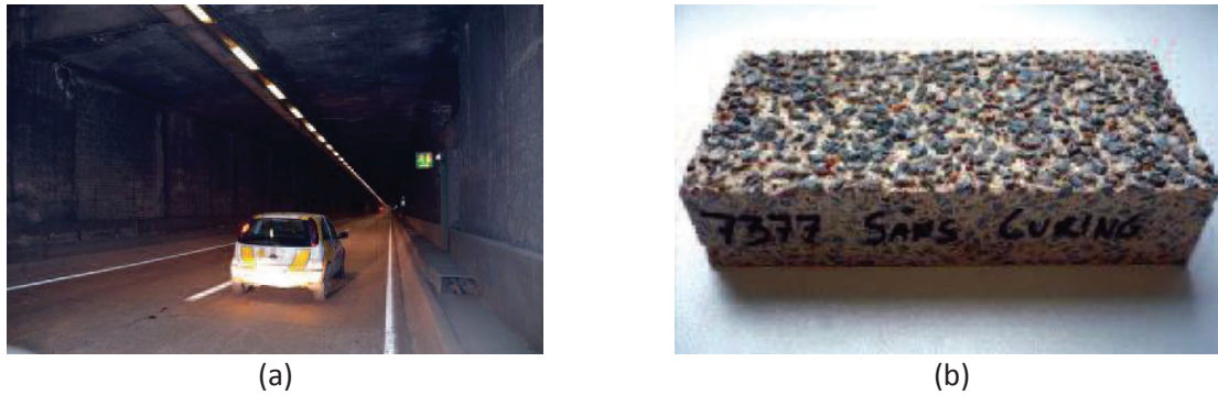
Figure 5. a) Vue de la section expérimentale du tunnel Léopold II à Bruxelles pour le projet PhotoPAQ 6 b) Béton photocatalytique déposé à Wijnegem pour le projet ECO2PROFIT 6
