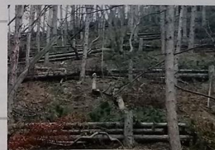
EROSION CONTROL HEDGES (PHOTO: PÁL KÉZDY)
