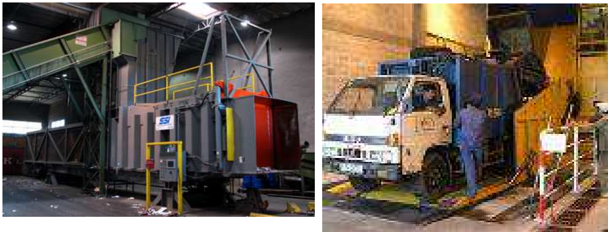
Figure 3 : La station de compactage d'ordures ménagères
