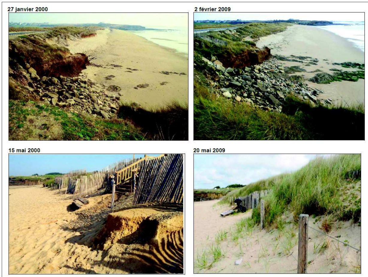
FIGURE 2.11 – En haut, vue de la plage du Loc'h entre janvier 2000 et février 2009, et en bas, confortement du pied de dune entre mai 2000 et mai 2009 (source : Geos/AEL et Lorient Agglomération).
