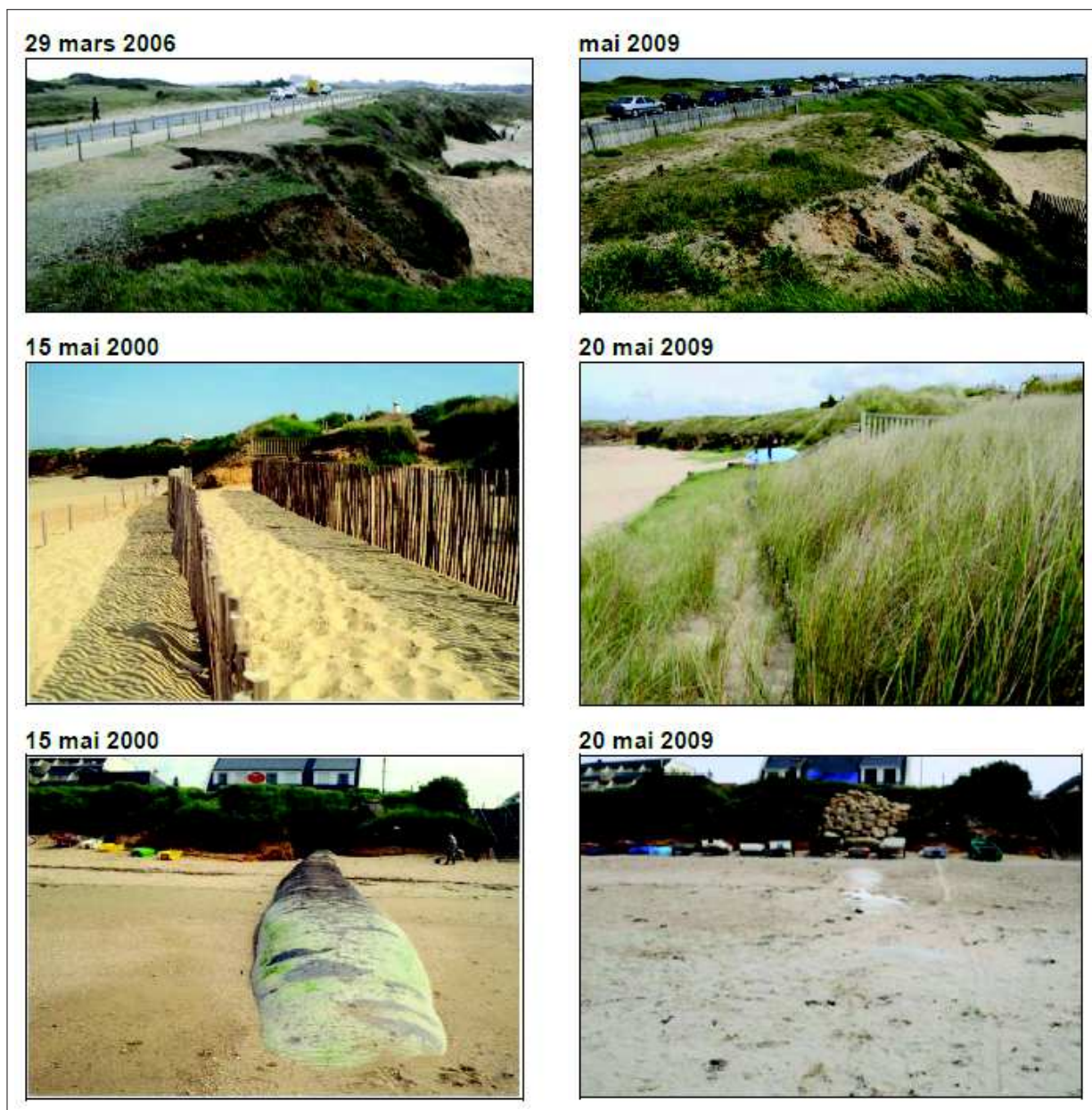
FIGURE 2.12 – Du haut en bas : évolution de la falaise Pen-er-Malo entre mars 2006 et mai 2009 suite aux travaux réalisés, renforcement du pied de dune entre mai 2000 et mai 2009, recouvrement du système Stabiplage et mise en place d'entrochements entre mai 2000 et mai 2009 (source : Geos/AEL et Lorient Agglomération).
