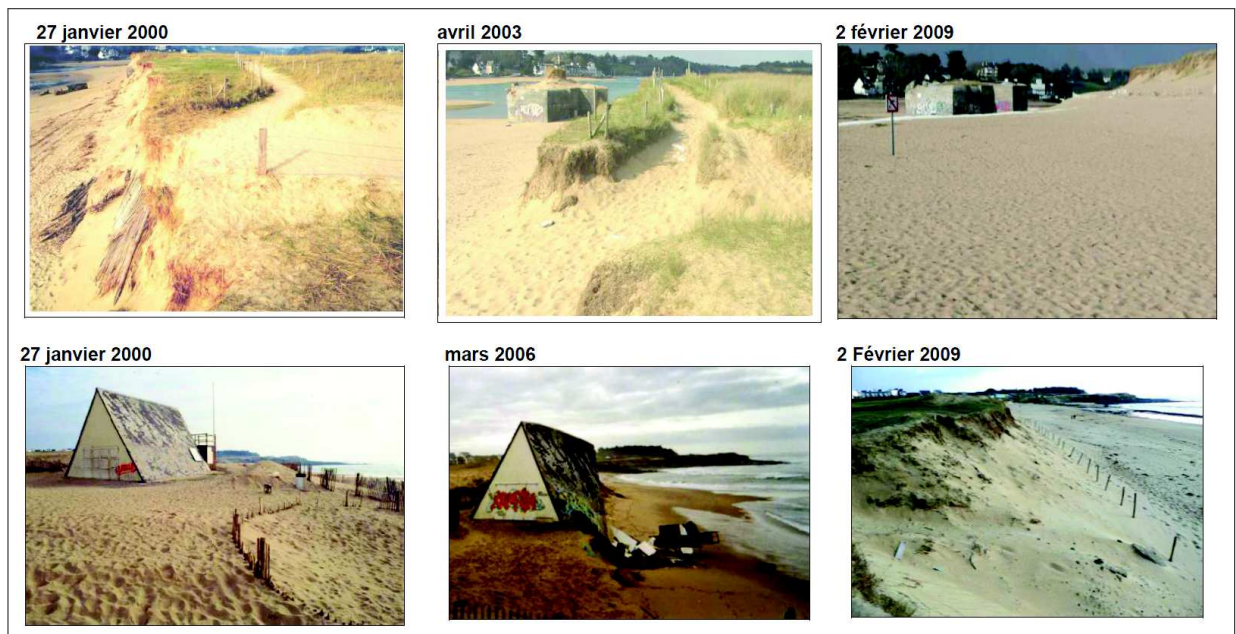
FIGURE 2.10 – En haut, recul du trait de côte au niveau du blockhaus entre janvier 2000 et février 2009, et en bas, recul du trait de côte au niveau du poste de secours entre janvier 2000 et février 2009 (source : Geos/AEL et Lorient Agglomération).
