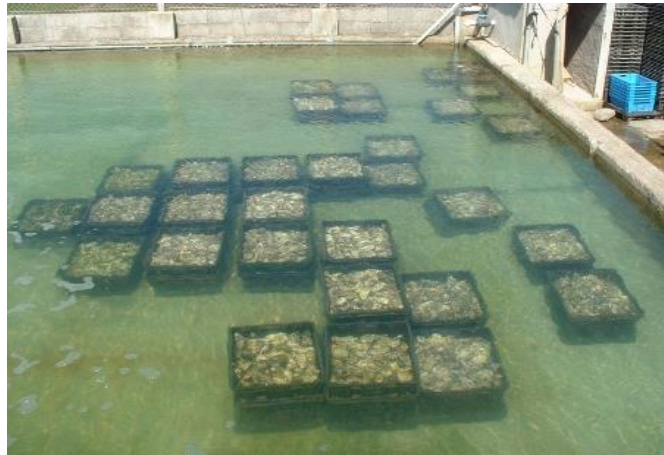
Figure 1.2. Bassin ostréicole ( http://www.lhuitrier.fr/ ). Les plus couramment utilisés sont en béton avec une légère pente pour permettre l'évacuation des eaux. Avant d'arriver dans le bassin, l'eau de mer est désinfectée soit par des procédés chimiques (ozone, chlore), soit par des procédés physiques (rayons ultra-violets).
