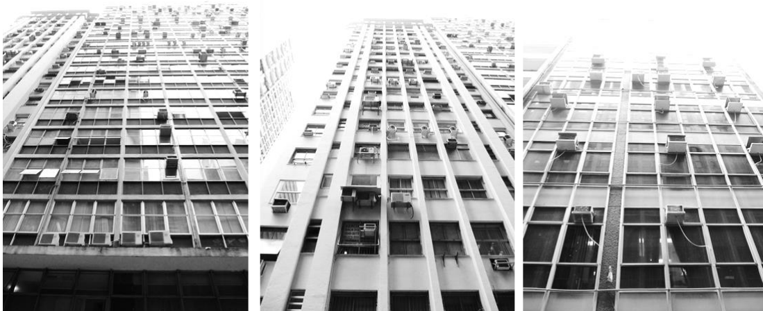
Figura 28 – Poluição visual nas fachadas gerada pelos aparelhos de ar-condicionado. Fonte: a autora.
