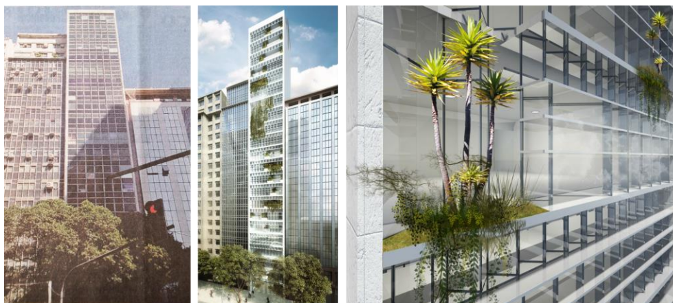
Figura 25 – Ed. RB12, antes e após reabilitação. Fonte: Globo (2014) e Arcoweb (2014b).
