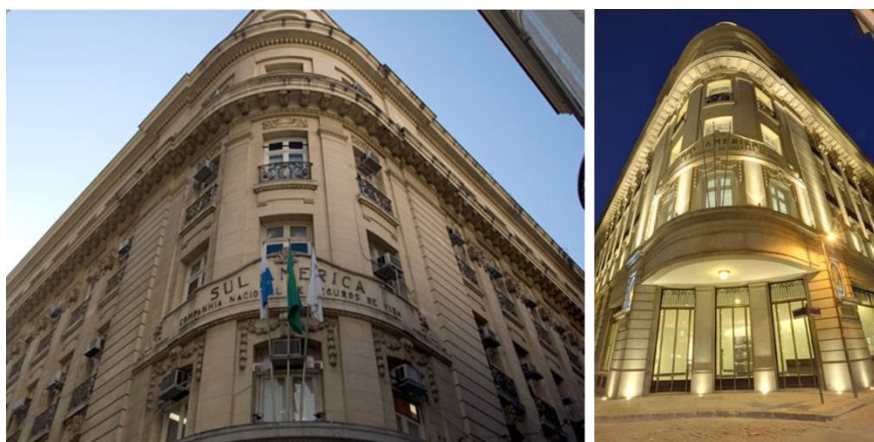
Figura 23 – Ed. Galeria, antes e após reabilitação. Fonte: Speyer (2011).
