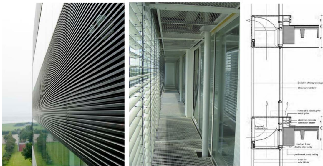
Figura 12 – Vista externa da grelha em alumínio, vista interna da fachada dupla e detalhe construtivo. Fonte: Beuvingmartensen (2005) e Baker (2009).
