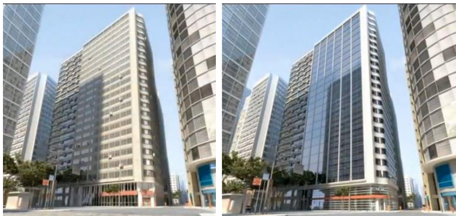
Figura 24 – Ed. Rio Branco 115, antes e após reabilitação. Fonte: BNCORP (2013).
