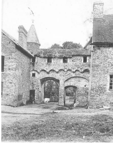
Figure 38 : La porte fortifiée du Manoir de la Seigneurie à Saint-Lô, vue intérieure (CP, détail).
