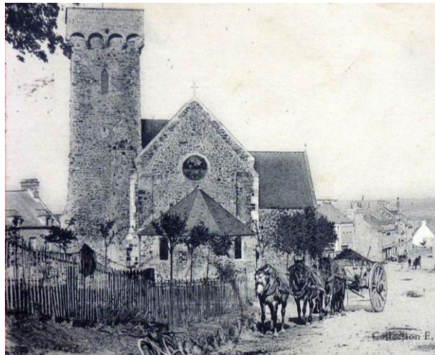
Figure 76 : L'église de Barneville et son clocher fortifié au XX e siècle (CP).
