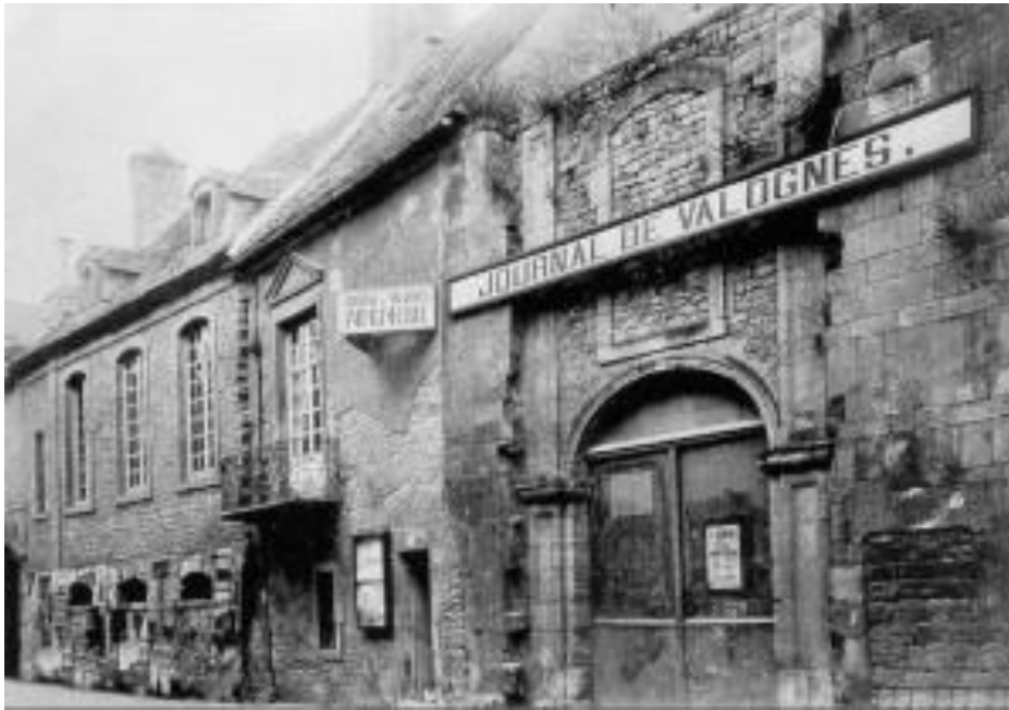
Figure 55 : Façade de l'Hôtel Lefebvre-Haupitois à Valognes, au début du XX e siècle. Communiqué par Julien Desbays.
