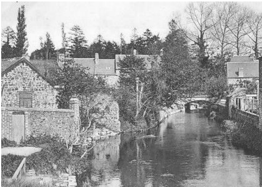
Figures 2 a & b : Vues sur l'ancien aqueduc de Contances et le quartier du pont de Soulles, au début du XX e siècle (CP)
