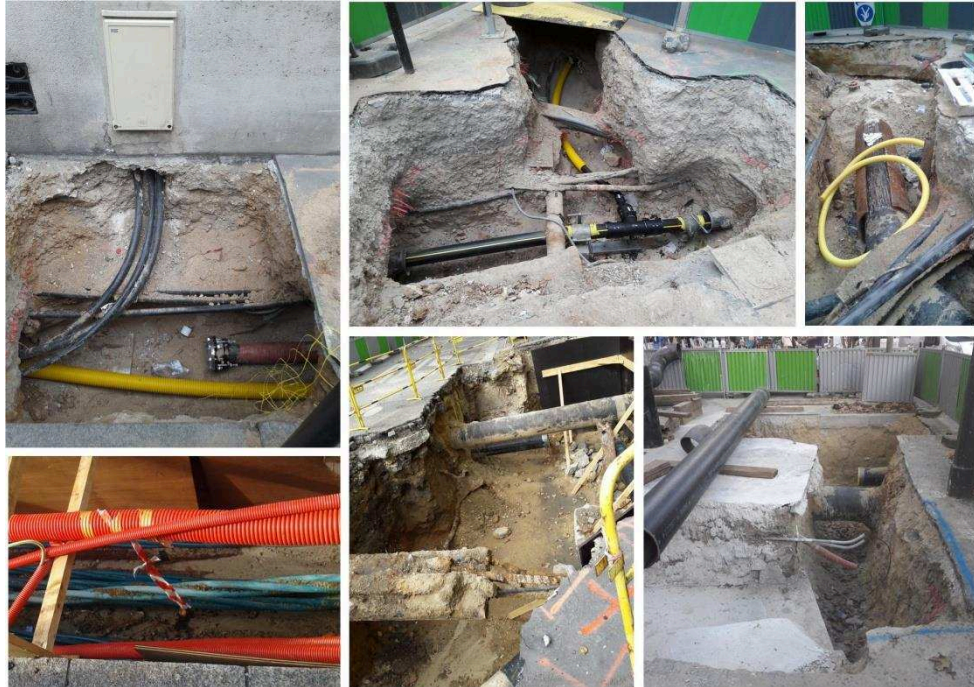
Figure 50 : Diversité des réseaux souterrains
