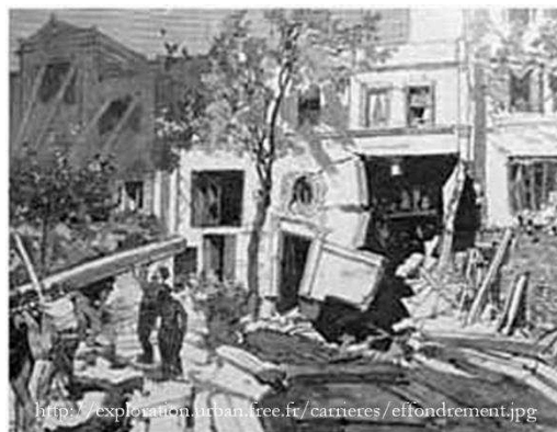
Figure 142 : Illustration d'un effondrement de carrière et Décret Royal pour la création de l'Inspection Générale des Carrières
