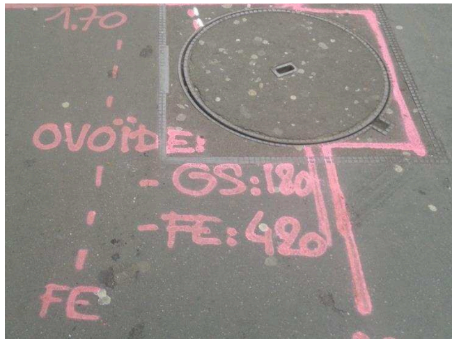
Figure 57 : Cas d'identification au sol d'une canalisation ovoïde
