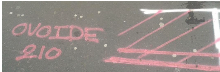
Figure 82 : Détermination d'une canalisation Ovoïde (Paris, 2016)
