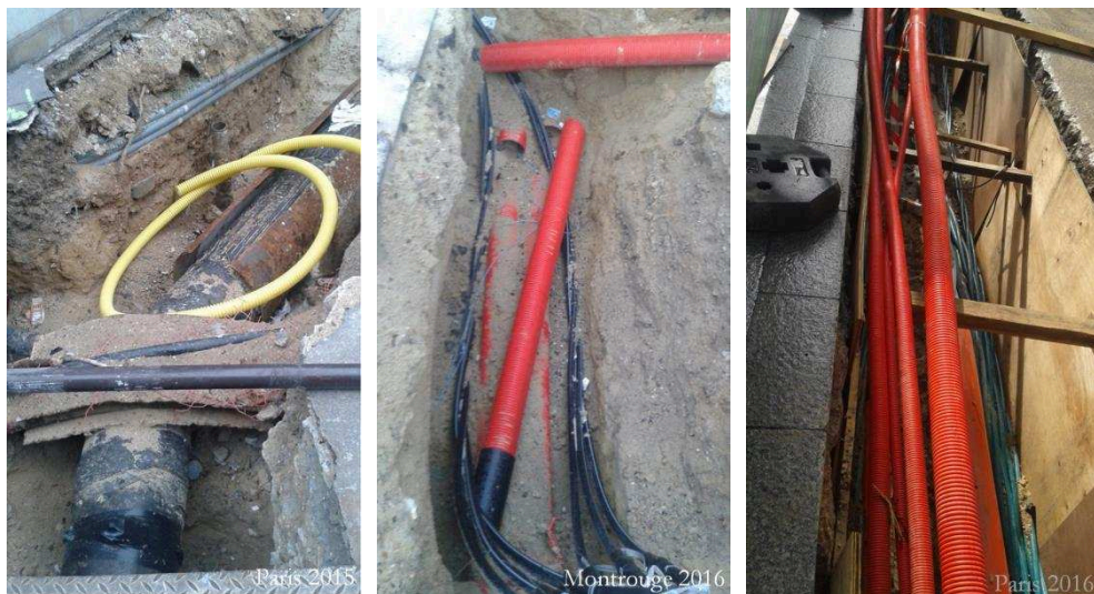
Figure 60 : Excavations avec des canalisations souterraines
