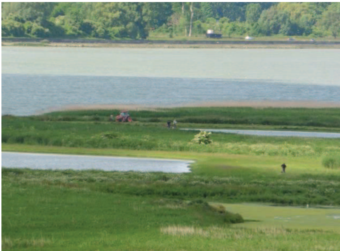
Image 63 - Chasseurs en train d'effectuer des travaux d'agrandissement d'une mare sans l'autorisation des gestionnaires de la réserve naturelle de l'estuaire. Aperçus au cours d'une visite guidée de la réserve. © M. C. Bellenger
