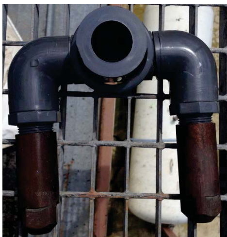
Figure 2.5 : Buses de pulvérisation
