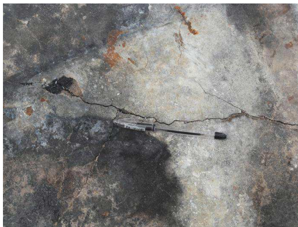
FIGURE 5 – Dégradation thermique.
