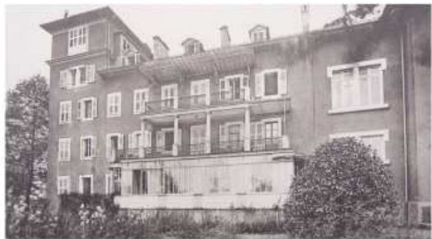
Façade nord du petit séminaire de Thonon-les-Bains
