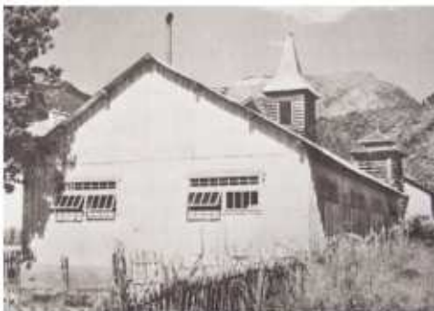
Ancienne église (provisoire) de Chedde Source: Eglise de Chedde..., op.cit.
