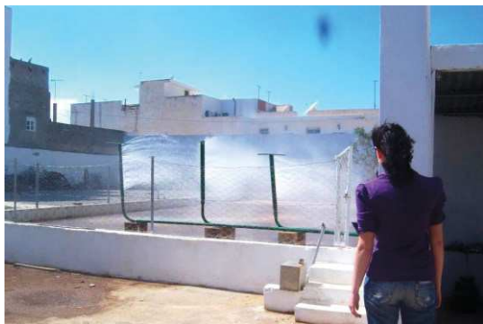
Photographie 9 (à gauche): système de refroidissement d'eau du réfrigérant. Photographie 10 (à droite): cuves de stockage 200 L. Photographies : C. Labadie – Albert Vieille SAS
