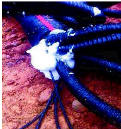
Image V : Mousse expansive empêchant l'infiltration d'eau dans les fourreaux.
