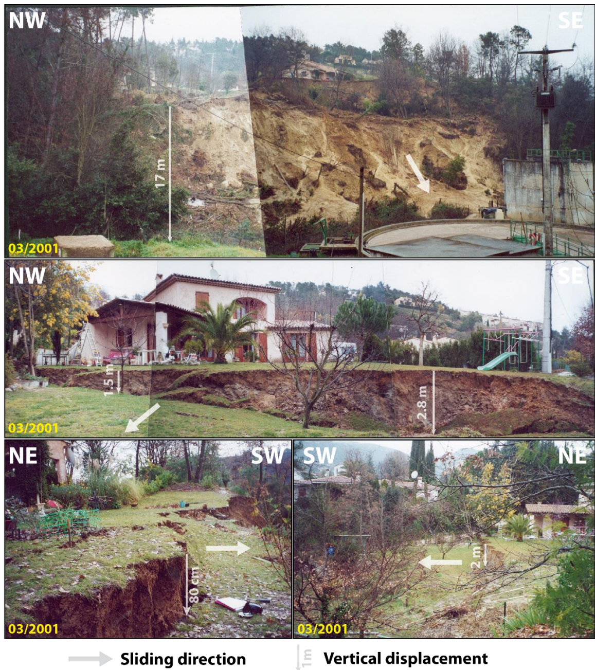
Figure 50 : Photos prises après l'évènement majeur de l'hiver 2000-2001.
