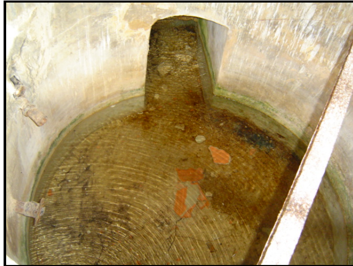
Fig. 226 : Vue intérieure d'un bassin circulaire. On remarque le canal reliant la conduite aux châteaux d'eau
