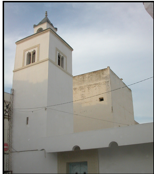
Fig. 272 : Mosquée bāb al-Ḥūma - Minaret
