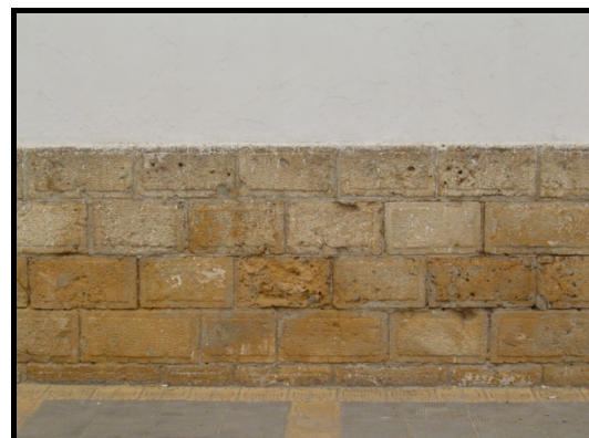
Fig. 80 : Les assises de pierres taillées des murs extérieurs
