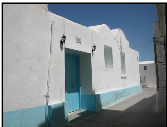
Fig. 314 : °Awsağa – al-ḡāma° al-qadīm La façade principale
