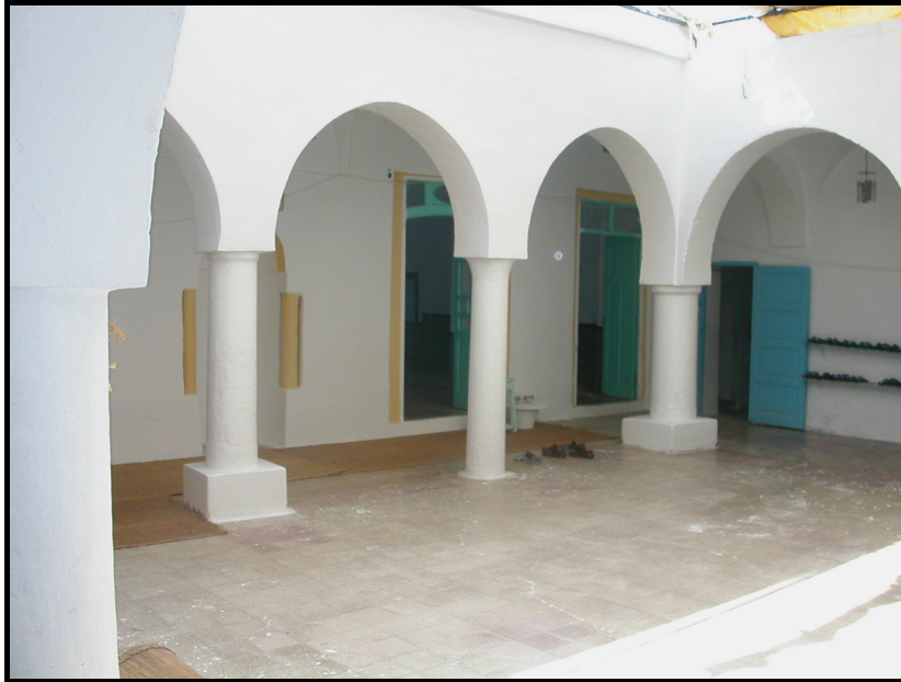
Fig. 324 : La cour de la grande mosquée d' c Āliya
