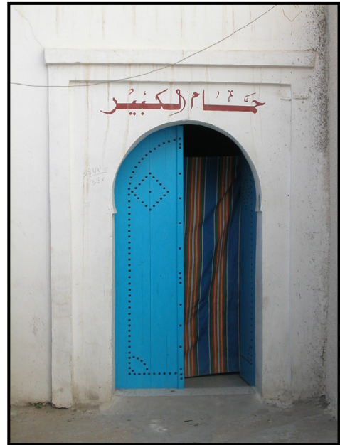
Fig. 294 : al-ḥammām al-Kabīr – la porte d'entrée
