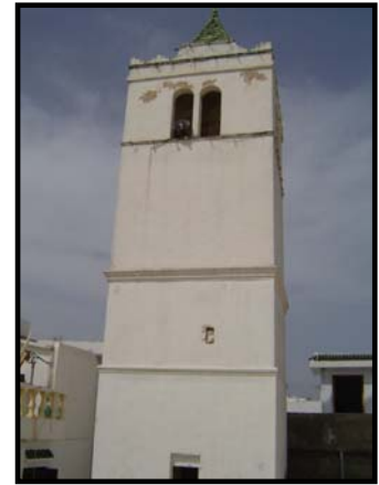
Fig. 28 : Le minaret – vue prise de la terrasse de la salle de prière
