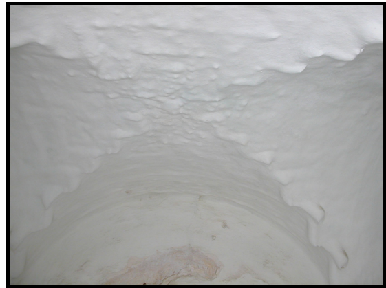
Fig. 290 : Lallā al-ʿAḡūla – détail de la toiture
