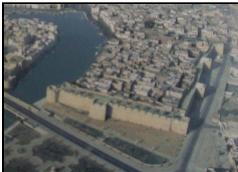
Fig. 43 : La casbah – vue aérienne
