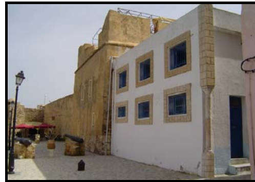
Fig. 30 : La façade nord de la mosquée et de la Qsiba aujourd'hui
