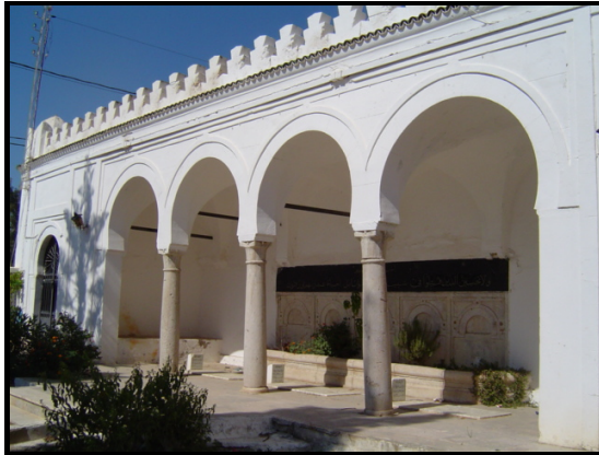
Fig. 208 : La galerie en avant des suçoirs
