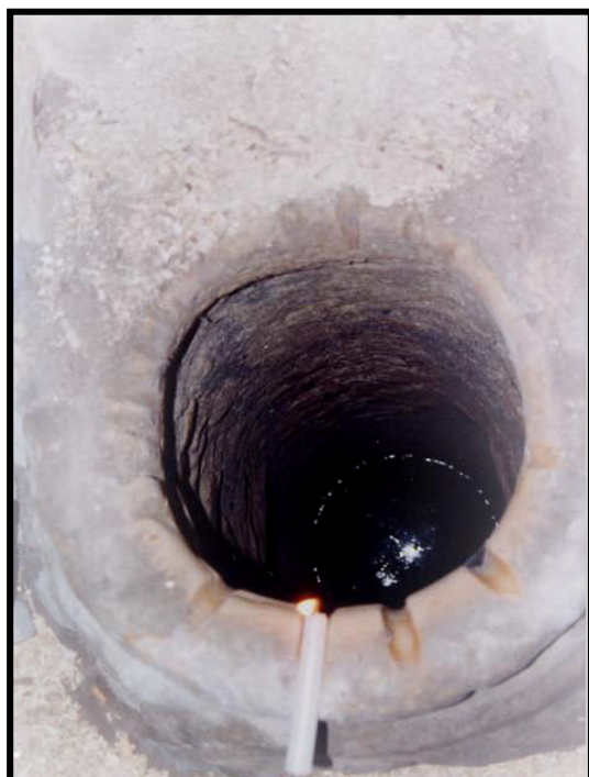
Fig. 66 : les rainures du rebord du puits
