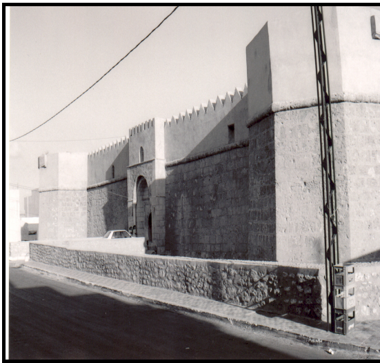
Fig. 152 : La façade principale du fort
