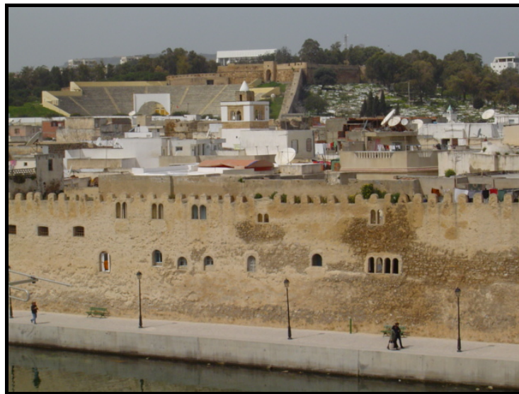
Fig. 42 : La casbah – vue de la courtine sud prise de la qṣība
