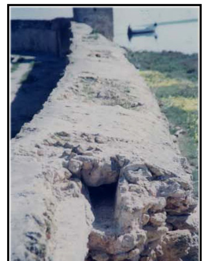
Fig. 183 : la conduite de l'enceinte -détail
