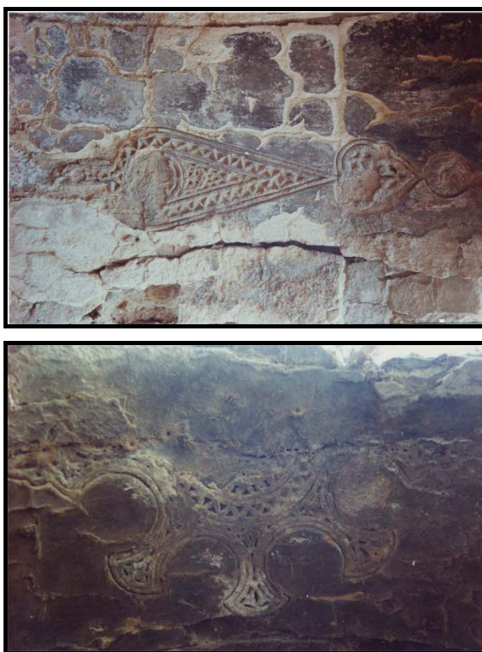
Fig. 185 : motifs décoratifs de la façade de la fontaine du port de Ġār al-Milḡ- Détails
