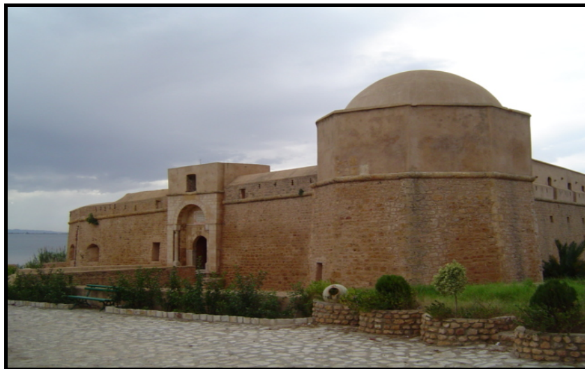
Fig. 144 : La façade principale du fort et le bastion d'angle nord-est
