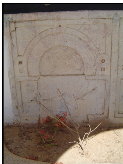
Fig. 212 : détail d'un arc aveugle
