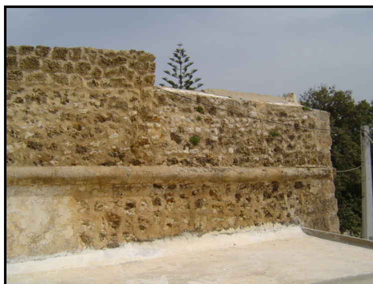
Fig. 17 : L'appareil du mur de l'enceinte - détail
