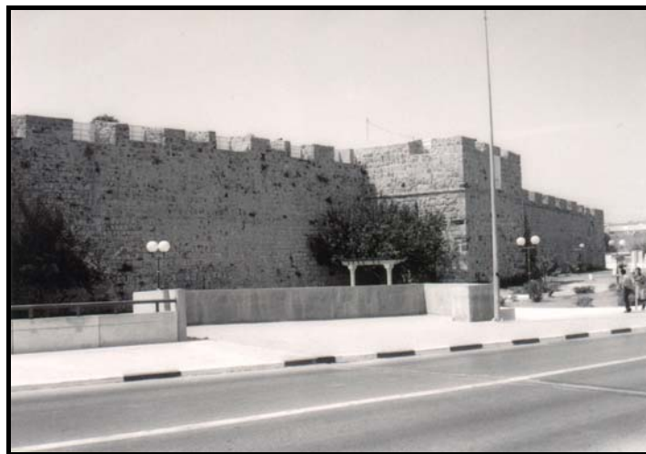
Fig. 37 : La courtine est – cliché pris du côté de la mer
