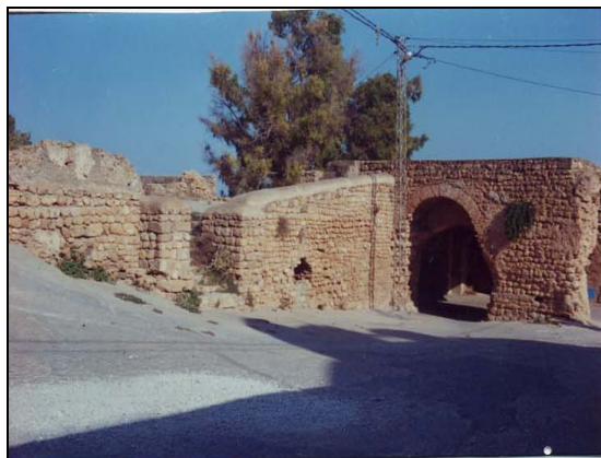
Fig. 177 : L'accès occidental du port
