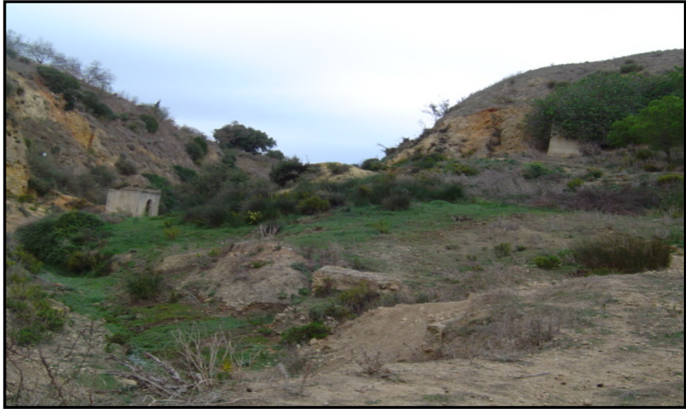
Fig. 223 : Le vallon de l'Oued Bürzām. On voit en avant-plan les structures, ruinées, de l'aqueduc et en arrière-plan les deux petits châteaux d'eau.
