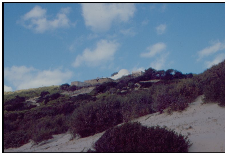
Fig. 222 : Mqām Sīdī al-Ḥāġġ Mbārik – vue prise du pied de la colline
