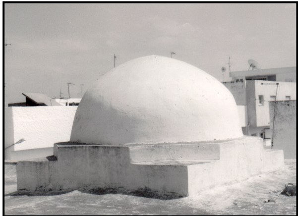
Fig. 259 : La coupole du miḥrāb – Vue prise de la terrasse
