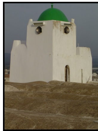
Fig. 130 : Mosquée Būṣaʿnūn - le minaret
