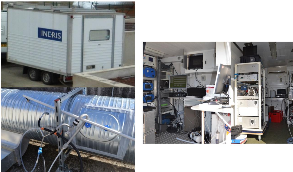
Figure 28 - Vue d'ensemble de l'implantation du parc expérimental déployé lors de la campagne tunnel
