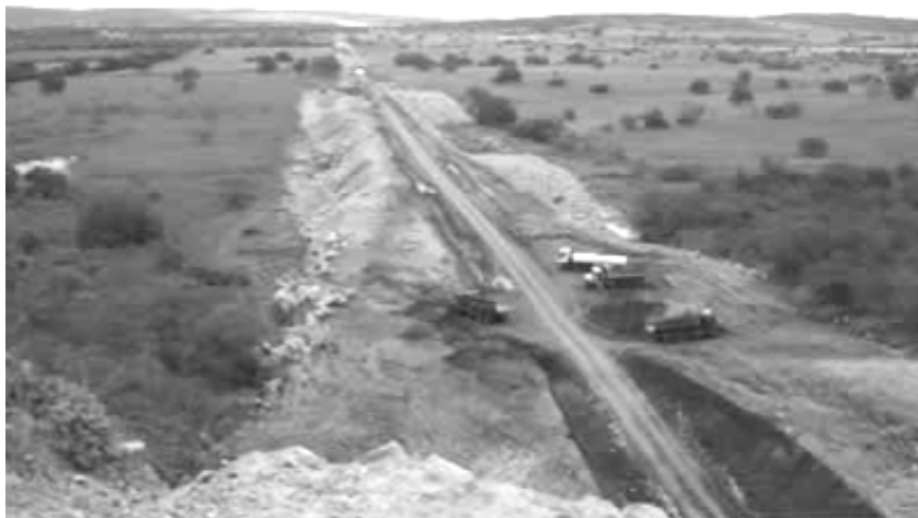
Travaux de la voie ferrée de la Transnordestine à Salgueiro (15/07/2009).
