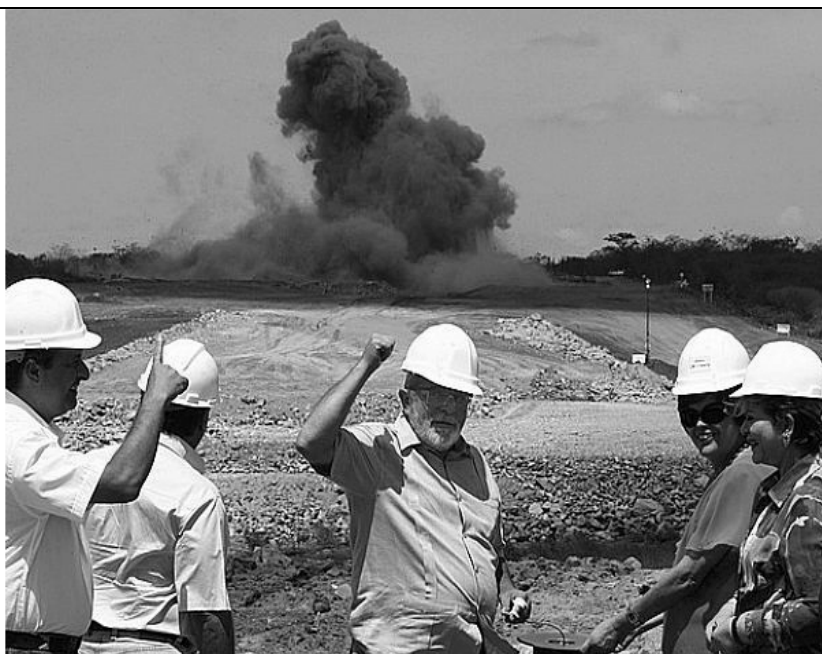
Visite du président Lula et de Dilma Rousseff aux travaux du PISF à Custódia –PE.
