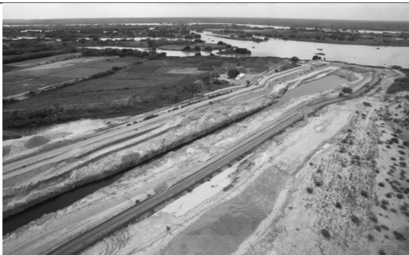
Travaux du PISF en Pernambuco le 02/06/2010.
