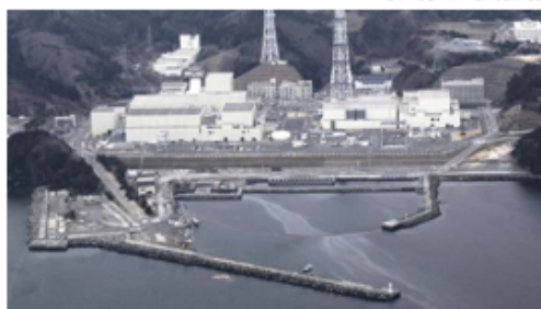
Vue aérienne de la centrale nucléaire d'Onagawa. (REUTERS)
