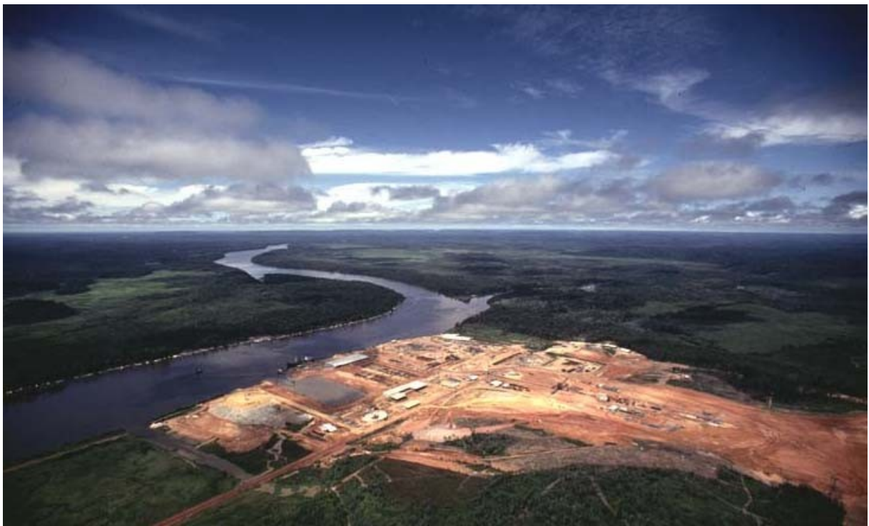
Photo 8. Vu du chantier du complexe industriel de Munguba, années 1975
