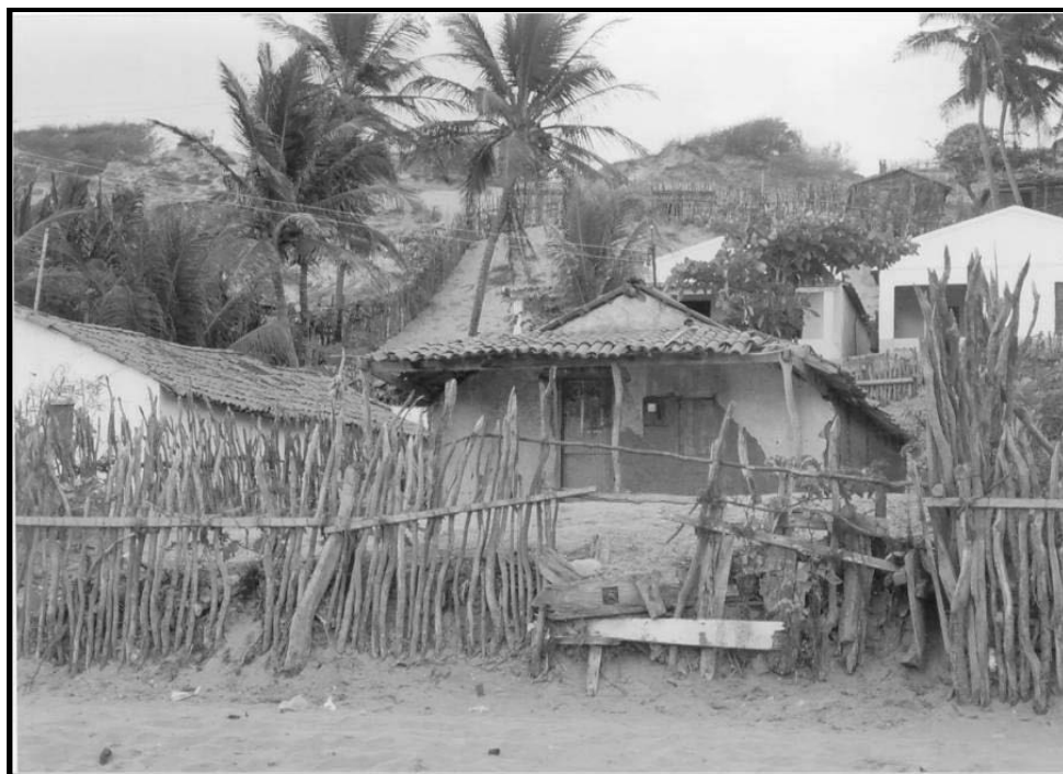
Figure 3 : Maison construite en torchis et avec tuiles traditionnelles
