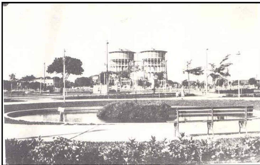
Figure 2 : Les chateaux d'eau
