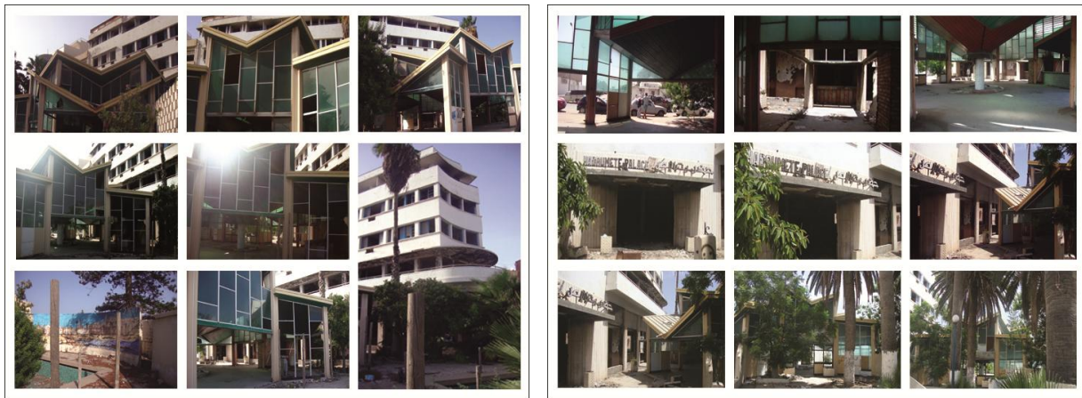
Figure II-12: Présentation de différentes façades de l'hôtel Hadrumète
