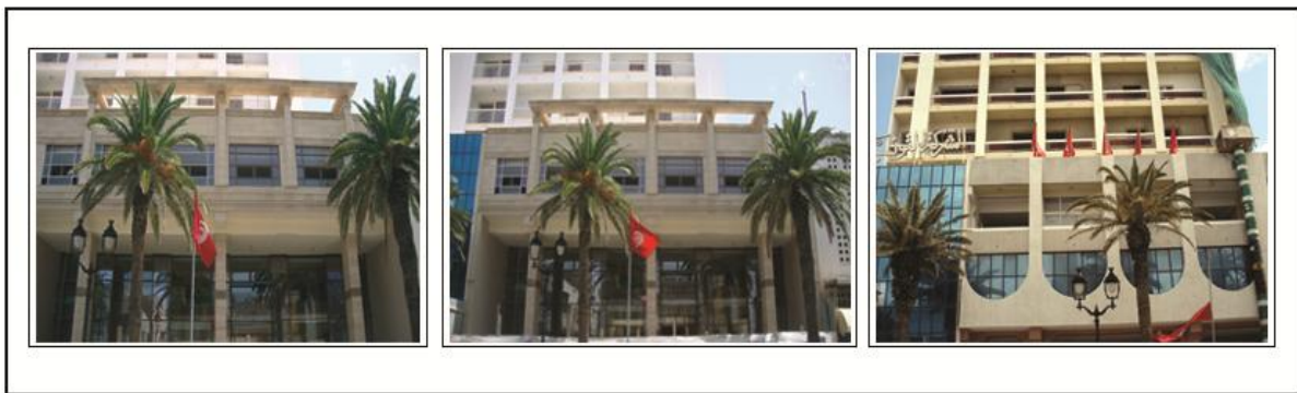
Figure III-3 : Vue plus rapprochée de la façade principale de l'hôtel Sousse Palace (côté rue)
