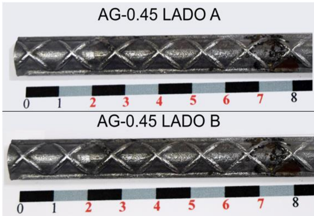
Fig. 92. Estado de la superficie localizada en el área de estudio de las varillas AG expuestas a ambiente controlado en laboratorio: relación a/c de 0.45.
