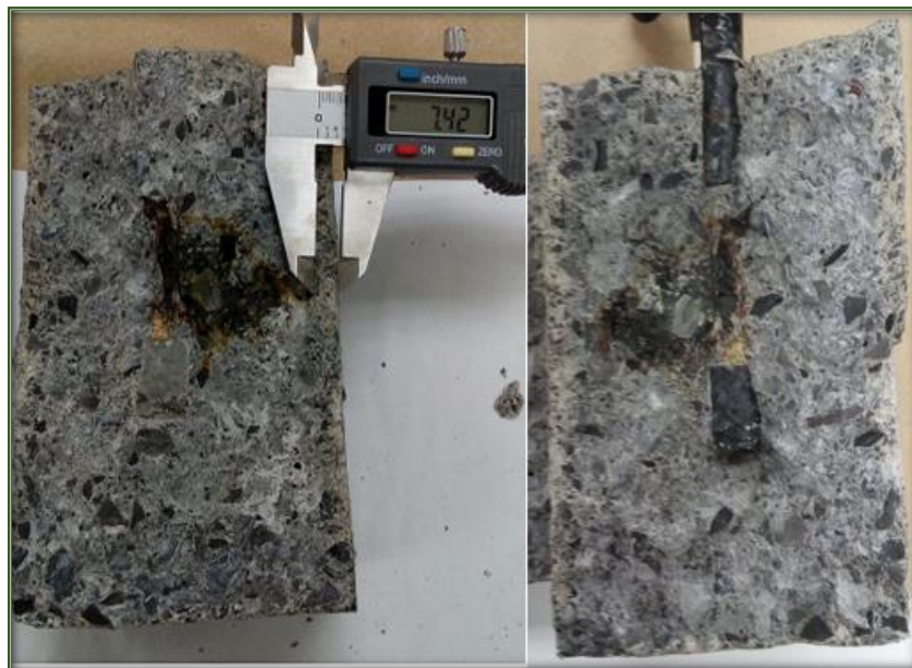
Fig. 85. Corte de un espécimen de concreto agrietado expuesto en ambiente controlado en laboratorio: AG-0.65. Sin presencia de manchas en la superficie del espécimen.
