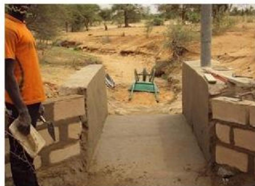
Section de mesure en construction
