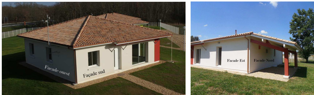
(a) Façades sud et ouest
