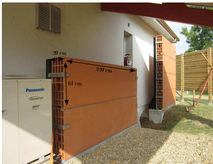
(a) Installation des réservoirs poreux
