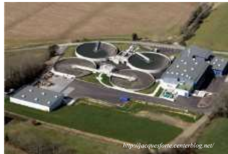
(g) Station de traitement des eaux usées
