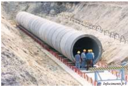
(d) Construction de réseaux
