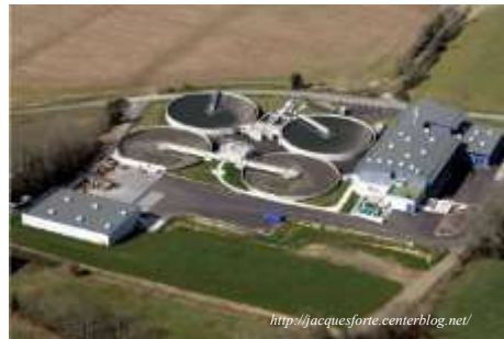
(g) Station de traitement des eaux usées
