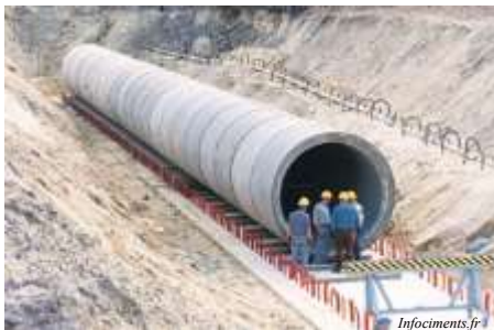
(d) Construction de réseaux
