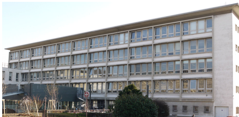
(b) Bâtiment de l'INSA
