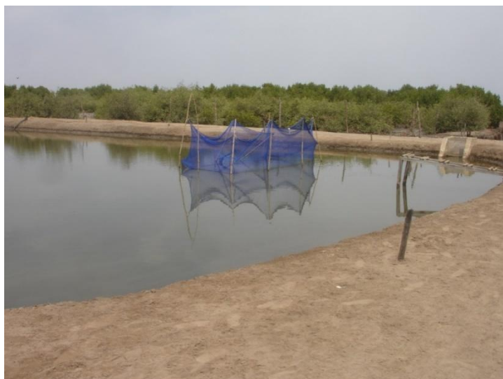
Photo 40: Un des bassins de la station d'alevinage de Tabor
