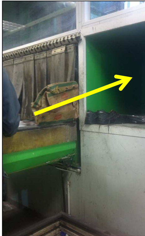
Figure 49 : photographie de l'exutoire pour les sacs de la cabine de pré-tri (CDT3)
