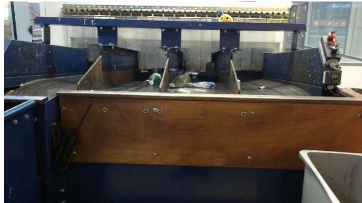
Figure 12 : poste de tri des corps creux (CDT4)
