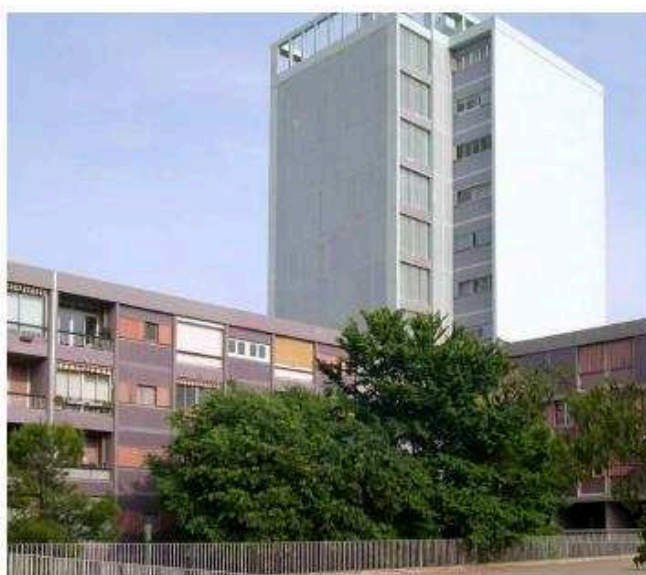
Façades depuis un cœur d'îlot.
