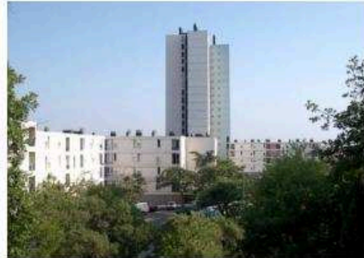
Vue sur la tour et les barres en équerre.
