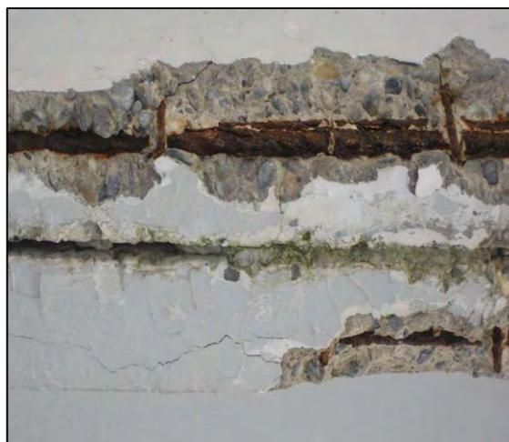
Figure I. 3 : Eclatement du béton d'enrobage dû à la carbonatation [Vu, 2011].
