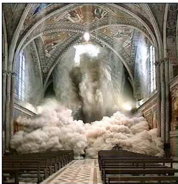
Figura 76. Crollo della volta della Basilica Superiore d'Assisi 26 settembre 1997
