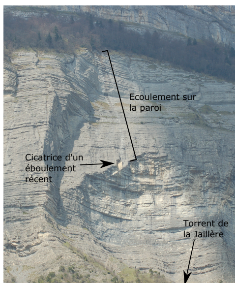
FIGURE 3.10 – Photographie de la paroi inférieure du Mont Saint Eynard montrant une trace d’écoulement au-dessus du torrent de la Jaillère (20/04/2015). On peut y voir une cicatrice d’un éboulement de 100 m 3 survenu le 18 janvier 2015.
