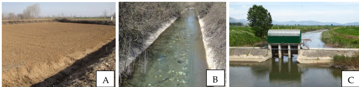
Figure 2.26 : Anthropisation des zones humides. A : Fossé de drainage creusé régulièrement autour d'une parcelle agricole située dans l'ancien marais de Tenaghi-Philippon (mars 2012, A. Glais) ; B : Canal de drainage cimenté, afin de chenaliser les écoulements des affluents du Kéfalari situé au nord-est de la plaine de Philippes-Drama (mars 2012, A. Glais) ; C : Barrage et station de pompage du drain artificiel principal de l'ancien marais de Tenaghi-Philippon (juin 2015, A. Glais).
